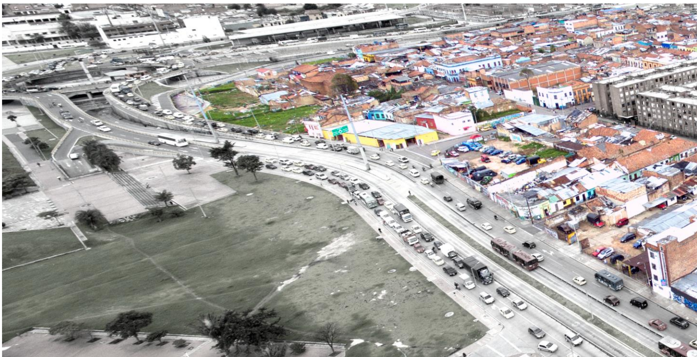
Imagen 6. Vista aérea del área de Implementación
