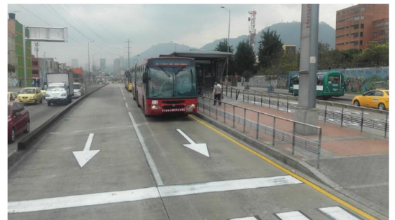
Imagen 12. Estación Transmilenio Hospitales
