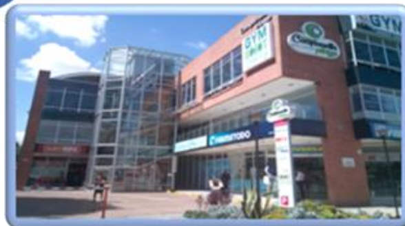
Oficina para centralizar Inspecciones de policía
