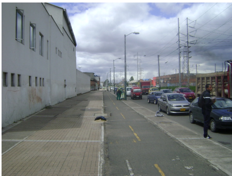
CICLO RUTA – CARRERA 39 CON AVENIDA CALLE 13 AL SUR- ESTADO ACEPTABLE.
