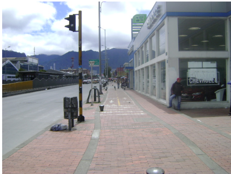
CICLO RUTA –AVENIDA CALLE 13 COSTADO SUR – AL ORIENTE- ESTADO ACEPTABLE.
