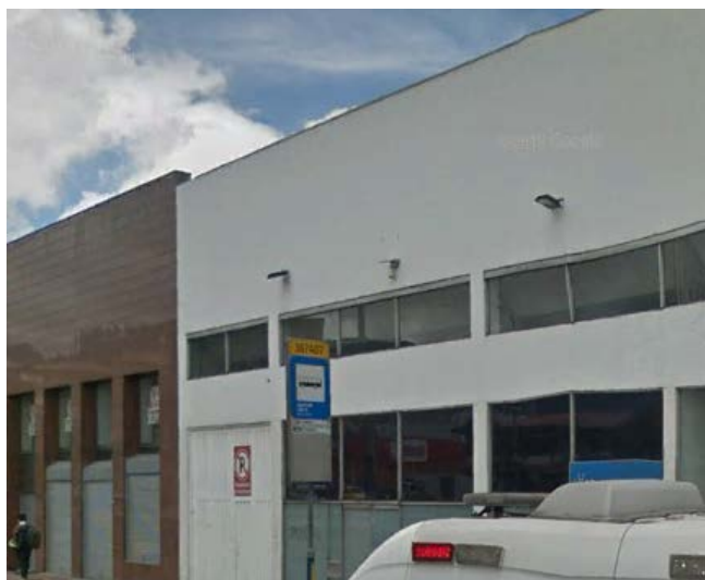
Avenida Calle 13 CON CARRERA 36 – PARADERO 367A 07 – RUTA 23
