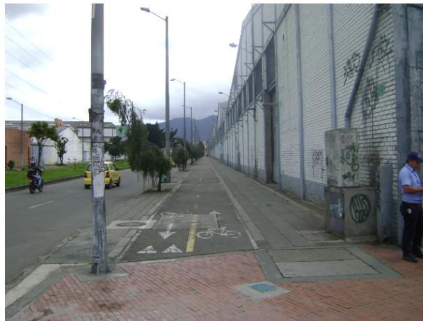
CICLO RUTA – CARRERA 39 CON AVENIDA CALLE 13 AL NORTE. ESTADO ACEPTABLE-FRENTE AL PREDIO DEL PROYECTO.
