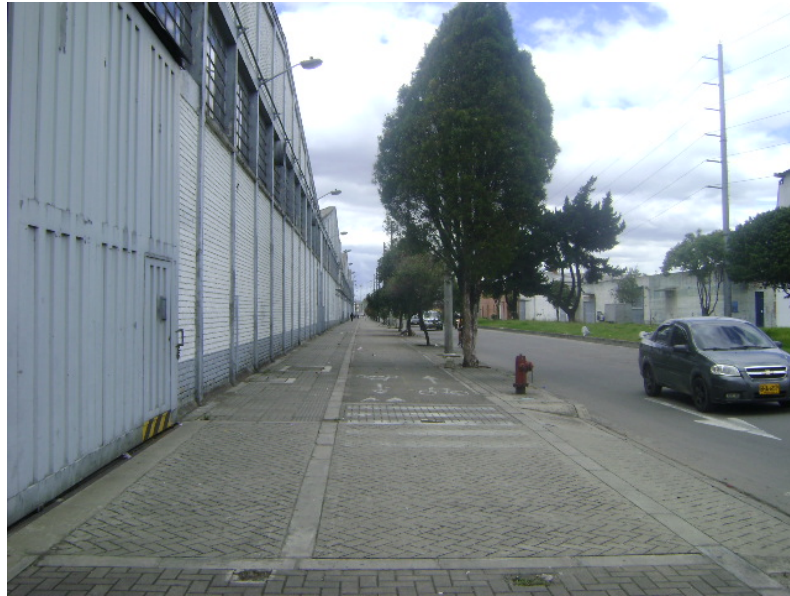
CICLO RUTA –CARRERA 39 CON CALLE 17 AL SUR -- ESTADO ACEPTABLE
