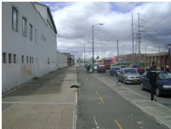
CICLO RUTA – CARRERA 39 CON AVENIDA CALLE 13 AL SUR- ESTADO ACEPTABLE – FRENTE AL PREDIO DEL PROYECTO.
