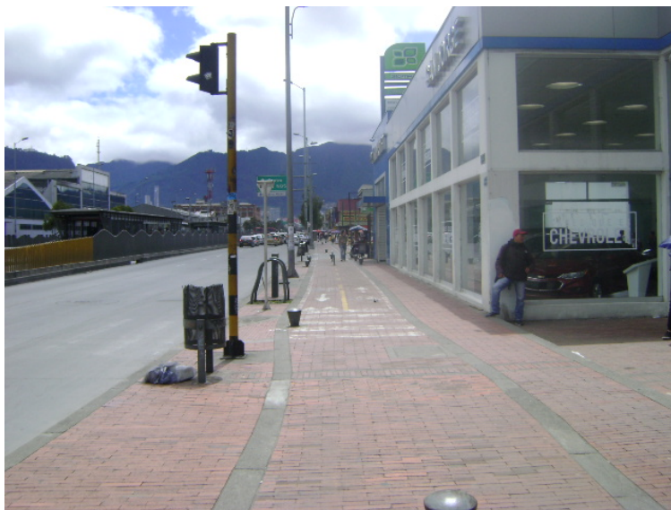
CICLO RUTA –AVENIDA CALLE 13 COSTADO SUR – AL ORIENTE- ESTADO ACEPTABLE.
