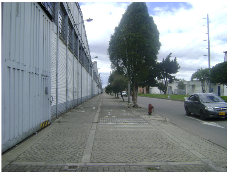
CICLO RUTA –CARRERA 39 CON CALLE 17 AL SUR -- ESTADO ACEPTABLE
