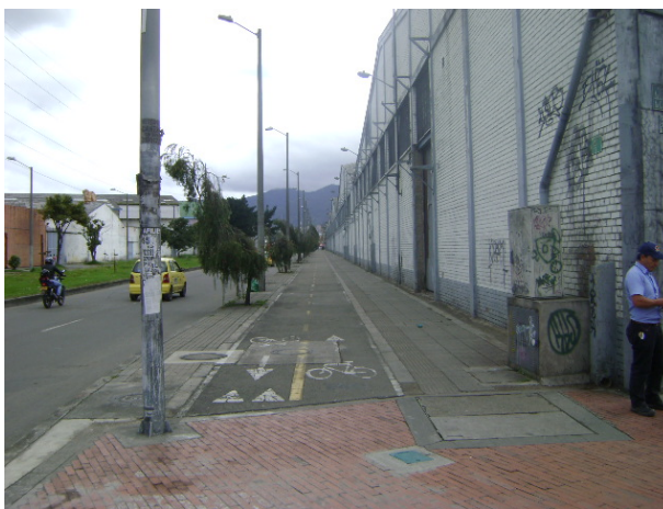
CICLO RUTA – CARRERA 39 CON AVENIDA CALLE 13 AL NORTE. ESTADO ACEPTABLE-FRENTE AL PREDIO DEL PROYECTO.
