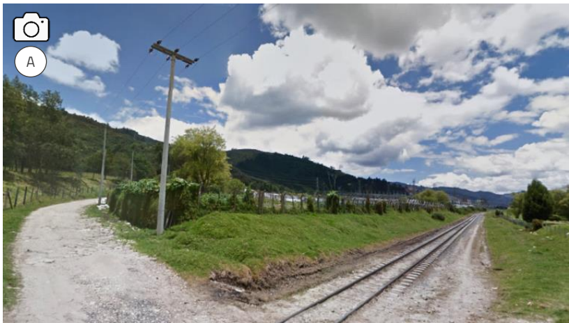
Ilustración 22: Estado Actual de la Vía Férrea a su Paso por el P.P. Las Flores Fuente: Google Street View
