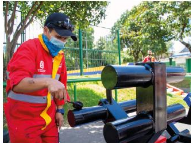
Mantenimiento de Malla Vial
