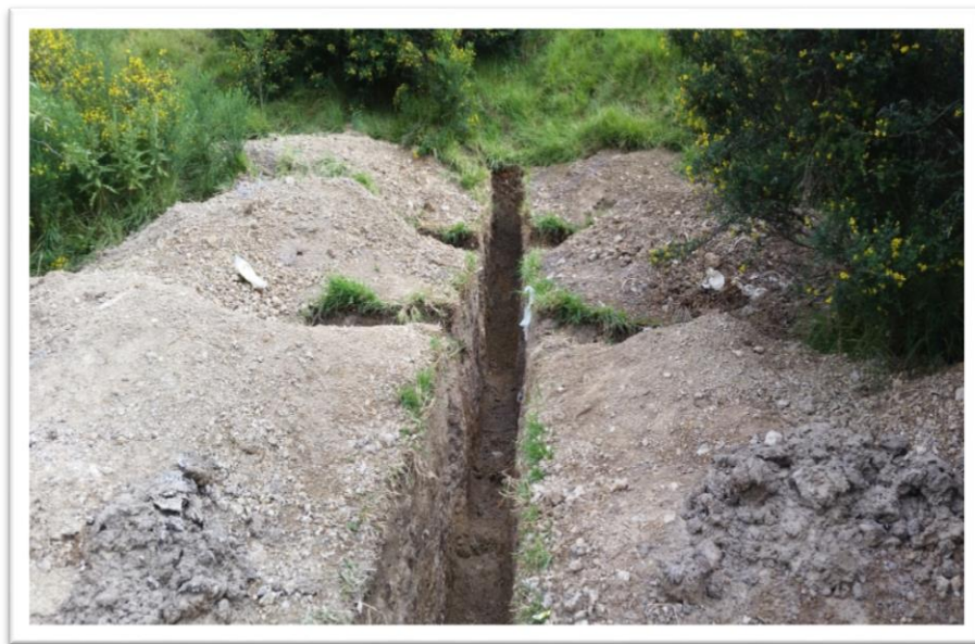
Foto 7. Construcción de canal paralelo a la pendiente siempre iniciando en un punto de saturación o donde convergen las pendientes, su profundidad depende de la distancia en la cual se encuentre suelo firme. Tiene un ancho de 0.50 a 0.80 m dependiendo de si es un canal principal o uno secundario. La longitud depende del punto de descarga el cual debe ser un lugar bien protegido (quebrada, río, alcantarillado etc.)
