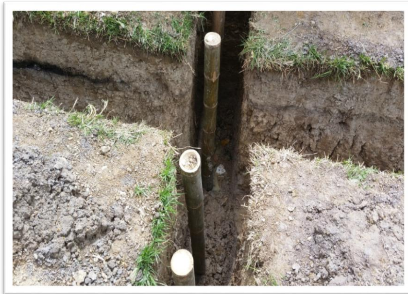
Foto 4. Se hacen cuatro hoyos con una profundidad de 0.70 m o más hasta encontrar terreno firme, y se distribuyen en los laterales sin que estos interfieran en el canal del filtro, estos deben quedar perfectamente alineados.
