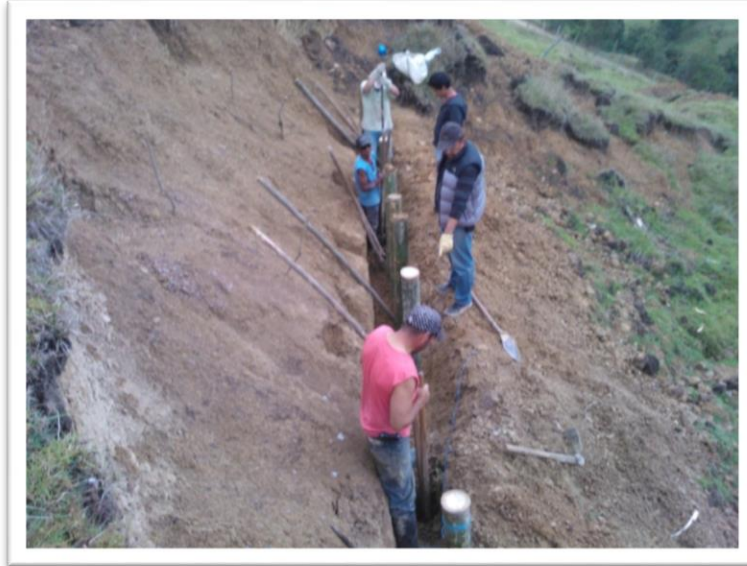
Foto 12. Ahoyado profundidad 0.70 m de la base de la zanja, se colocan postes de guadua los más gruesos a una distancia de 0.20 m al inicio y final de la zanja y los restantes a una distancia de 0.70 m.
