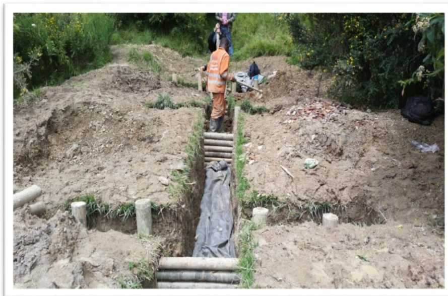
Foto 9. Una vez se tenga la altura especificada se recubre preferiblemente con pasto o con geotextil de no contar con otro material natural.
