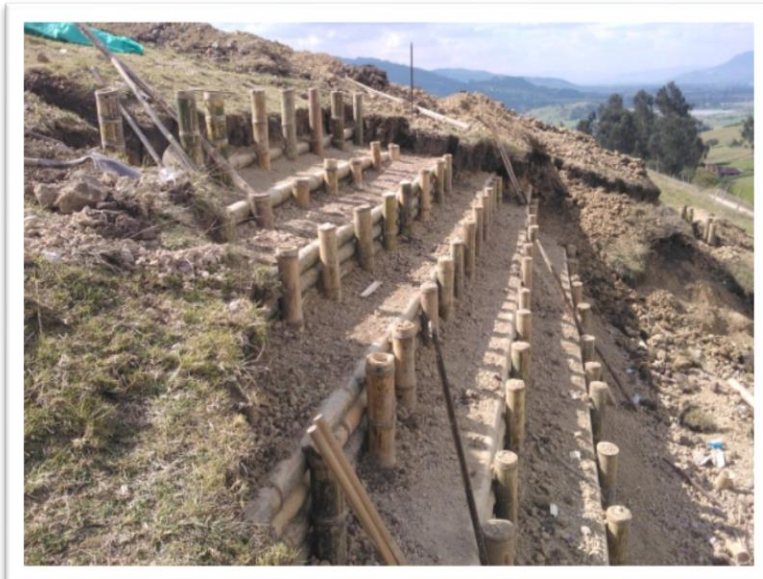
Foto 15. Terraza terminadas y compactadas, estas deben tener un ligero grado de inclinación con el fin de permitir que el agua de escorrentía discorra con facilidad por sobre esta y evitar el encharcamiento, y están listas para siembra del material vegetal.
