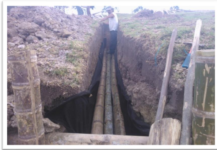
Foto 8. Una vez construido el canal con los trinchos vivos, se procede a montar el filtro como tal, se reviste preferiblemente con camas de pasto o con geotextil en ausencia de otro material natural, se colocan camas de guadua superpuesta una sobre otra cubriendo la base, y se eleva hasta la altura que se define en el trincho.
