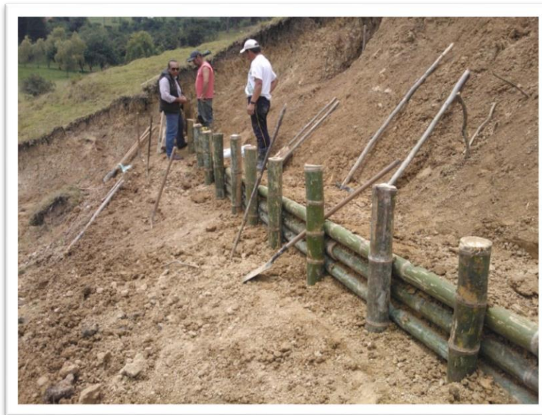
Foto 13. Armado de la primera cortina de guadua, con la colocación de guadas superpuestas formando un balcón o terraza con un altura promedio de 0.80 m, se rellena con el mismo material de la excavación y se compacta con pisón.
