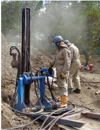
Figura 1: Equipo Tipo Mesa Hidráulica de Perforación para proceso de instalación de Drenes Horizontales.
