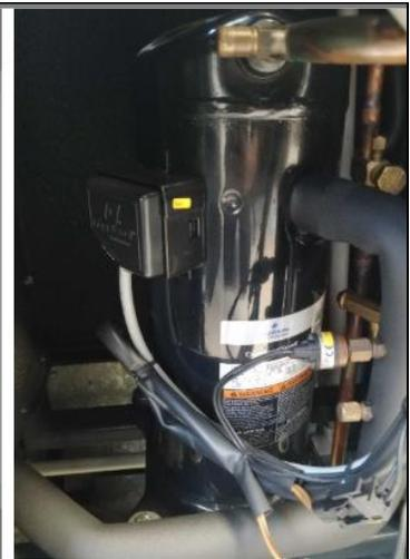
Revisión de acumulador de succión y modulo Inverter: Revise que el acumulador de succión no tenga fugas de gas refrigerante líquido. Por otro lado revise el estado general de limpieza del módulo inverter. Revise las válvulas de servicio, que no existan manchas de aceite en los gusanillos y no se evidencien fugas. -
