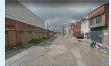
Tipos de vía V-6, se encuentra en mal estado, la vía no está pavimentada, transita tráfico mixto, los andenes también se encuentran en mal estado y son usados para almacenar basura.
