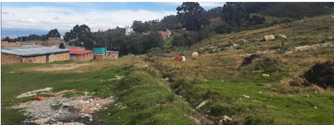
**Ilustración 67. Foto de acequia de drenaje construida para proteger el barrio El Quindío de escorrentías durante las lluvias**
