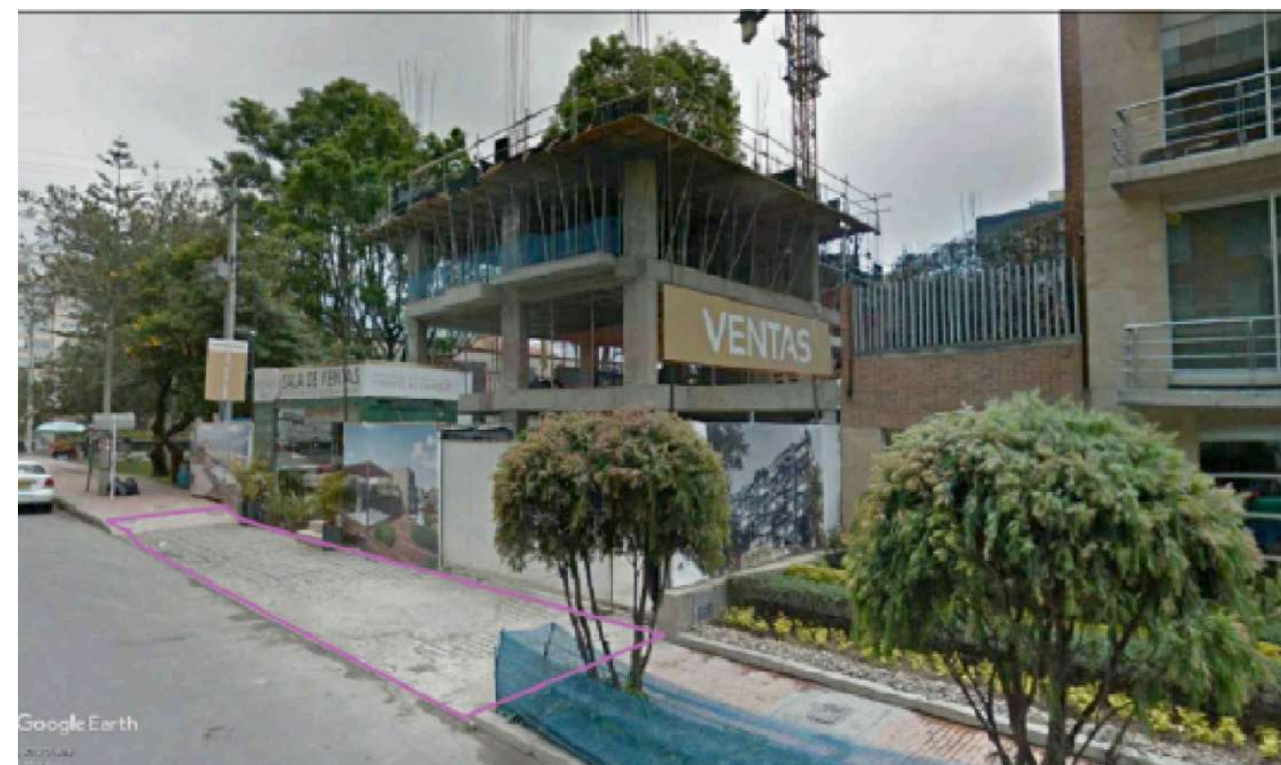
ESTADO ACTUAL CALLE 97
