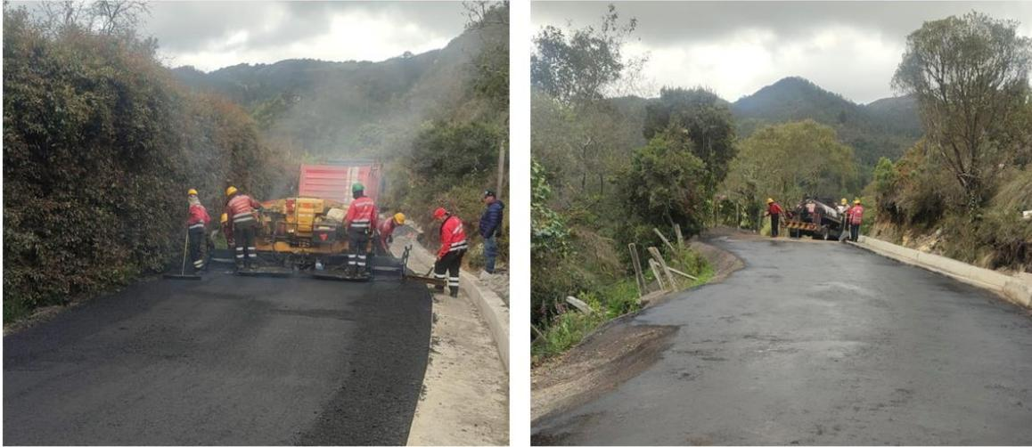
Imagen 42 y 43 Ejecución de las obras de la malla vial rural, vereda Verjón Bajo
